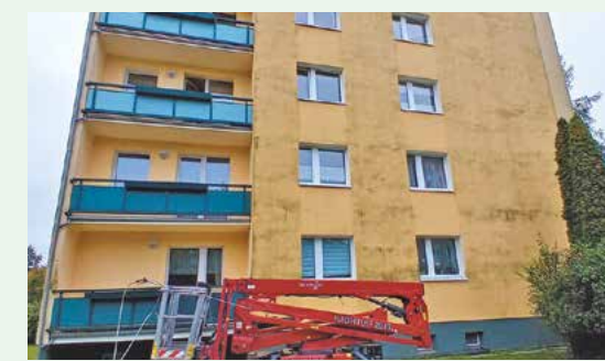
Vorher: Die Hebebühne der Firma AlgenStar vor einem SWG-Wohnhaus auf dem Schomborg.
